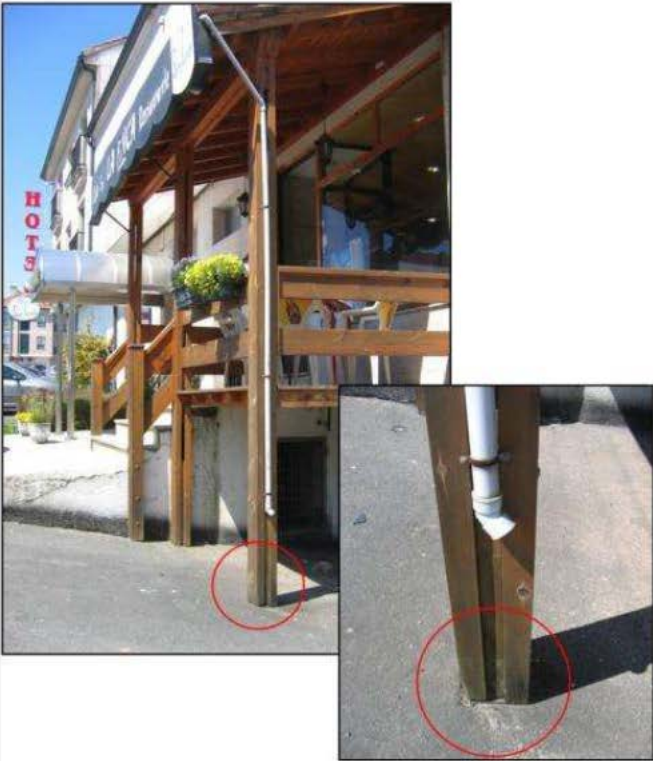
Detalles constructivos con Picea abies
